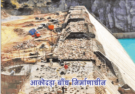
आकोदड़ा बाँध निर्माणाधीन
